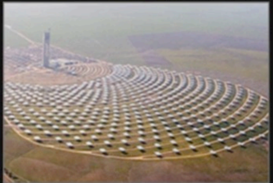
Planta Solar 10, Sevilla, Spain, 11MW
