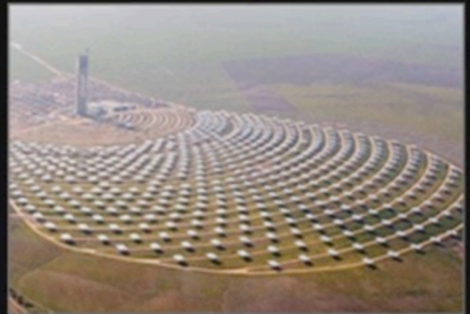
Planta Solar 10, Sevilla, Spain, 11MW
